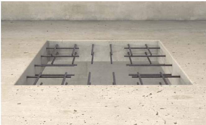
Schließen einer Deckenöffnung
